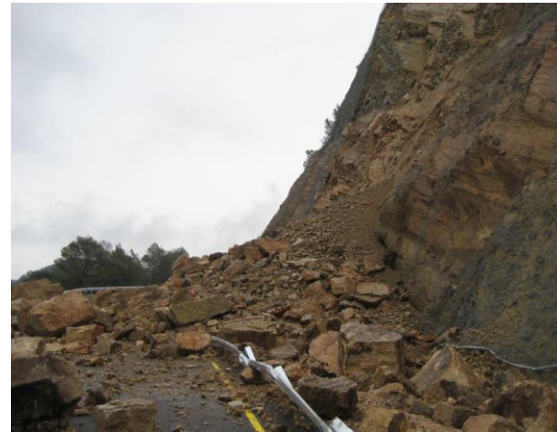
Prat de Comte landslide
