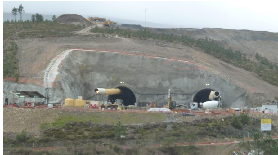
Corga de Vela east portal
