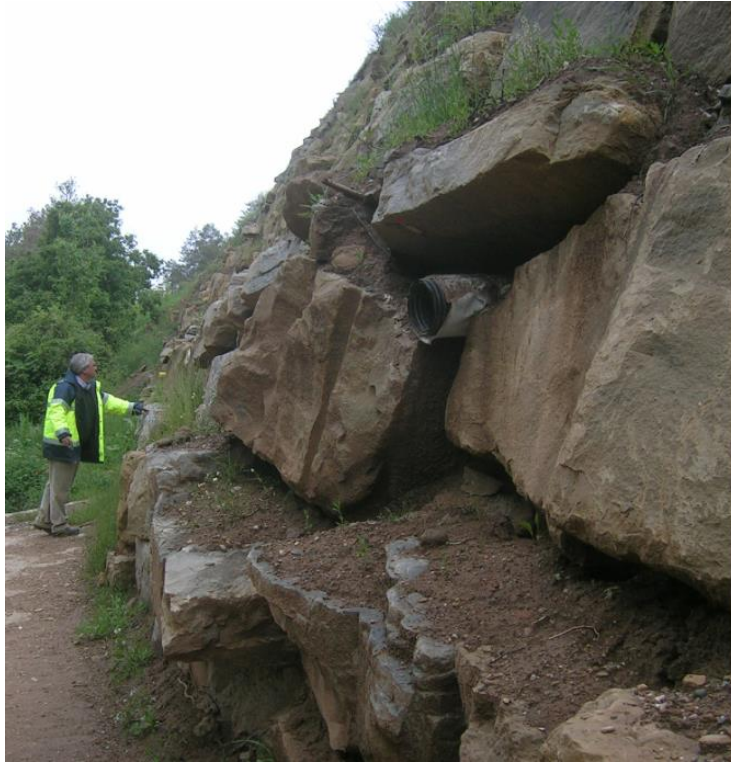
Castelltercort wall reinforcement
